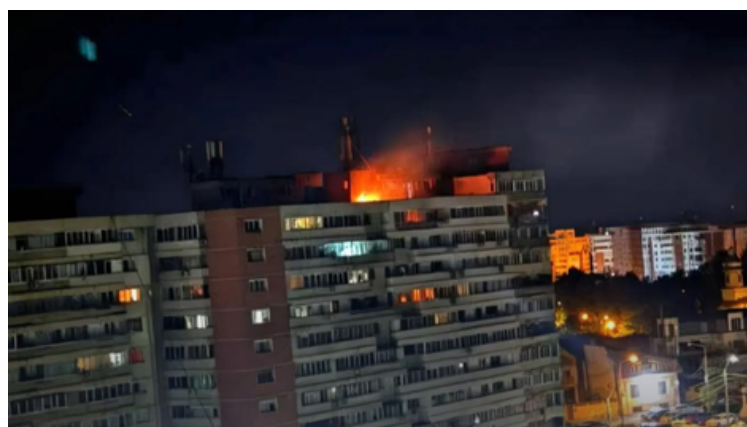
Impactul explozibil al dronei asupra blocului din Galați. Sursă foto: IGSU
